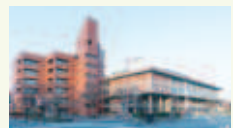
前川建築のひとつ「弘前市庁舎」
